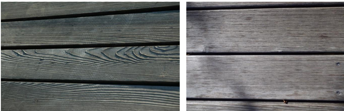
Abbildung 3 a und b: Ablösen der flach angeschnittenen Jahrringe auf der „rechten“ Brettseite bei Lärche (links) und schieferarme Oberfläche bei gebürsteter Lärche mit stehenden Jahrringen (Rift - rechts)
