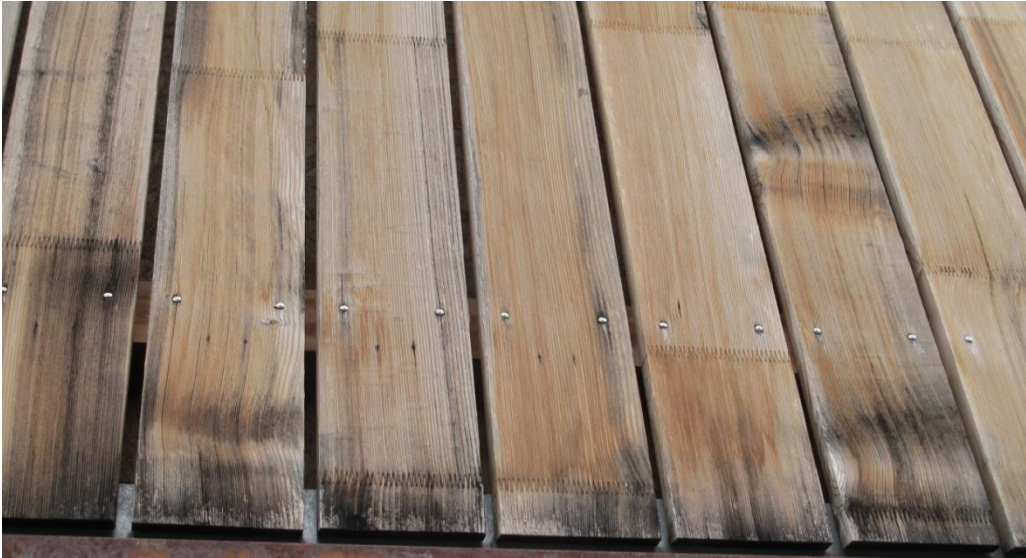
Abbildung 3: Die Keilzinkenverbindungen sind nach 8 Jahren Bewitterung in einem hervorragenden Zustand
